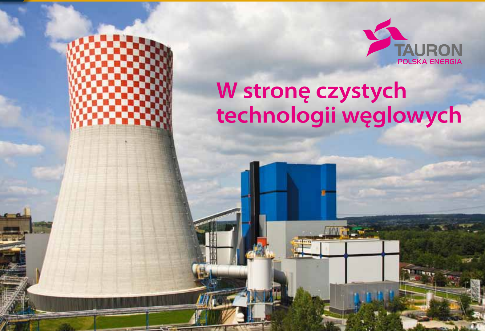
Blok 460 MW w Elektrowni Łagisza oddany do eksploatacji w 2009 roku
